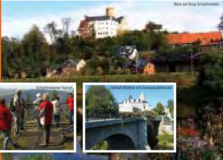
Blick auf Burg Scharfenstein
